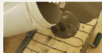
recouvrement de mortier autonivelant
