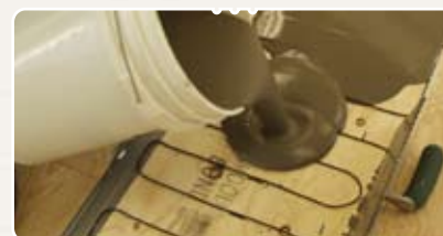
Recouvrement de mortier autonivelant
