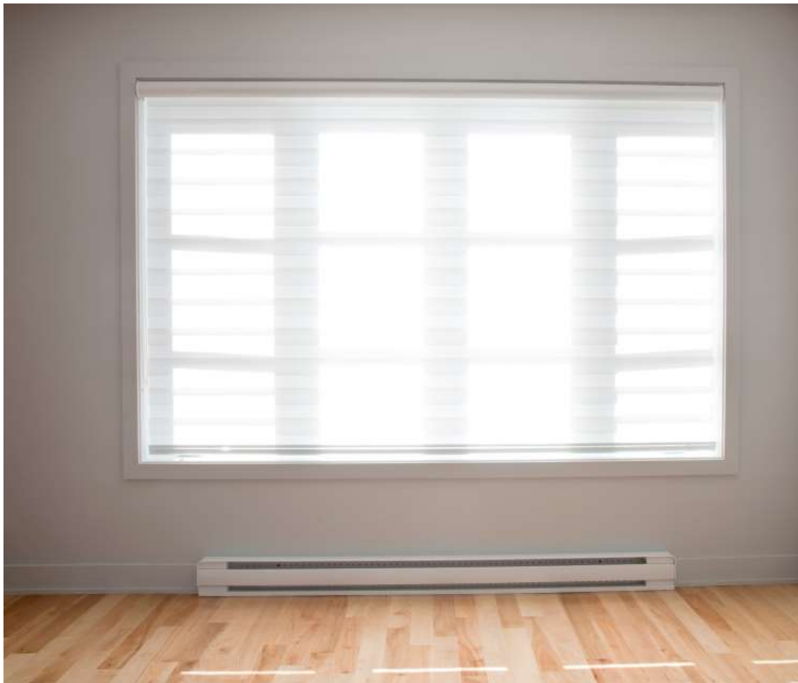
Image 1 – Plinthe électrique installée sous une fenêtre
